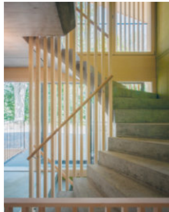
Der Treppenhauskern ist massiv ausgeführt, die übrige Konstruktion ein Holzbau.
